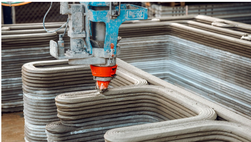
Obrázok č. 213: Proces tvorby domu pomocou aditívnej výroby — špecializovanej 3D tlače [19]
